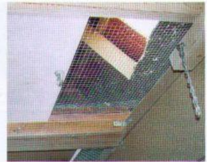
Die Luftzuführung kann mit Schiebern reguliert werden!
